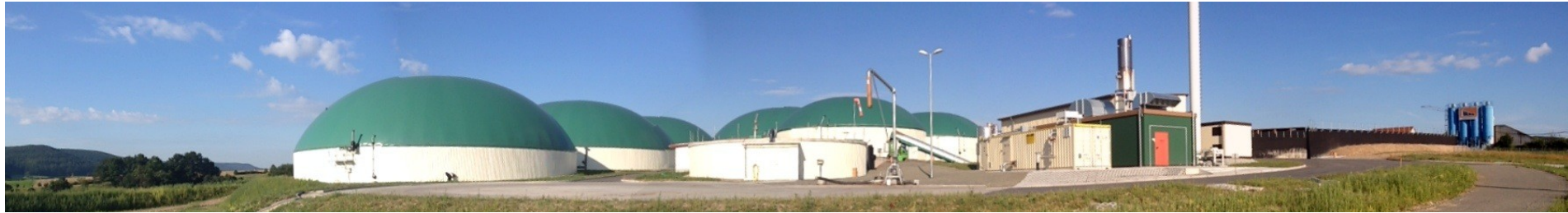
Nr. 55: Biogasanlage Rippershausen (1.216 kW el, 6 gasdichte Behälter, 1 BHKW, 2 zusätzliche Satelliten-BHKW, 6,5 km Gasleitung nach Meiningen)
